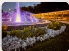
Kolonáda v Luhačovicích, památka UNESCO, prošla unikátní obnovou.
